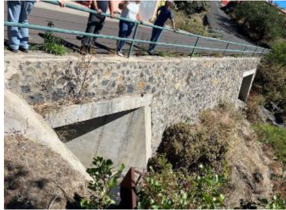
Fin de la obra de fábrica, la boca del barranco de Mederos es la izquierda de la foto (calle El Vardito)
