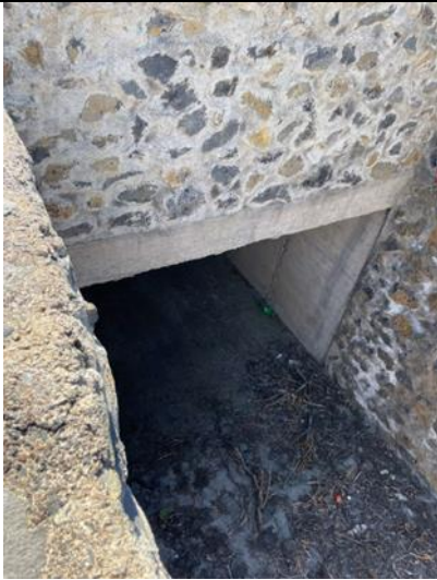
Inicio de la obra de fábrica del Barranco de Medero, en la Calle Asomada del pueblo
