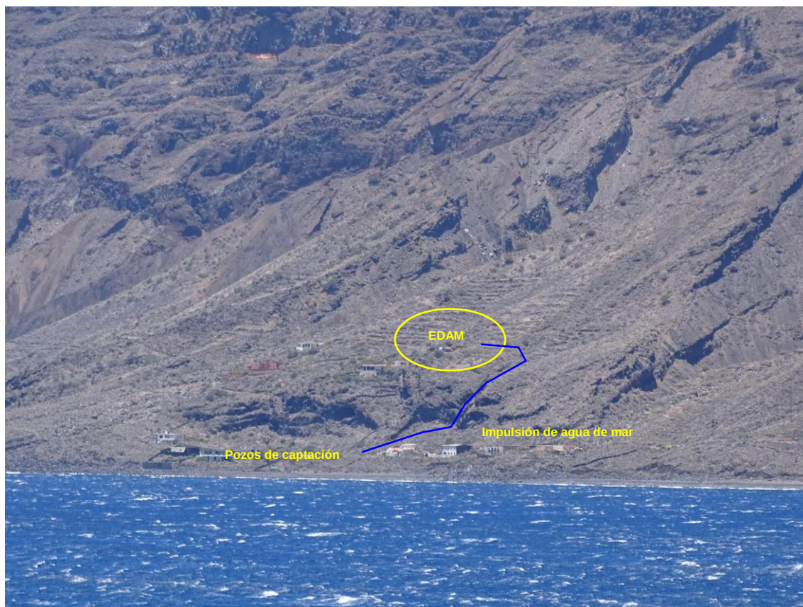
Vista ampliada de la zona de actuación.
